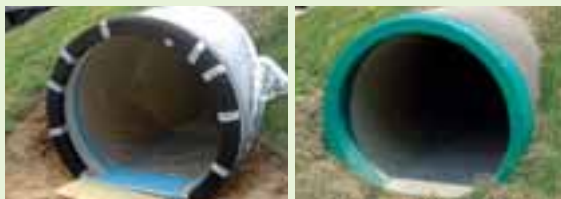
▲コンクリート素材のヒューム管にクッション材を巻き（左）、その上から特殊コーティング剤を吹きつけて完成（右）。
